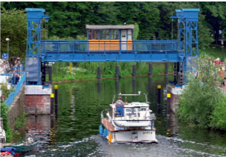
Fluss Elde, Hubbrücke in Plau am See
