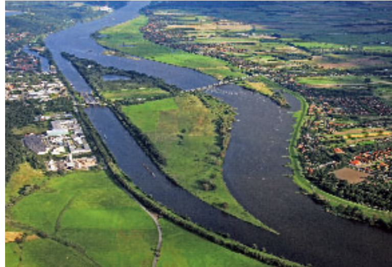
Elbbrücke in Geesthacht, Schleswig-Holstein
