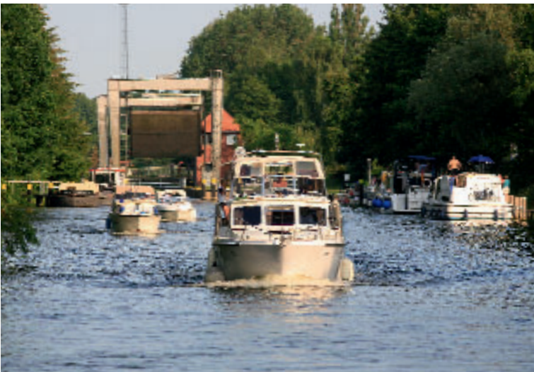
Hubschleuse in Mirow, Mecklenburg-Vorpommern
